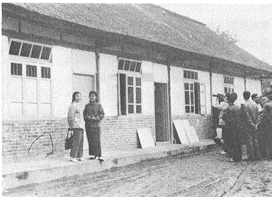
写真 3 都江発電所 (成都西方) 大衆観測点
