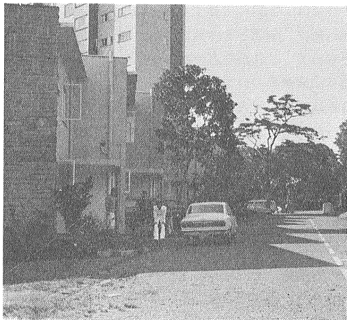
写真1 ナイロビの一角にある外国人向の住宅 深い緑の中に建つこの住宅は小人数の家庭向である
