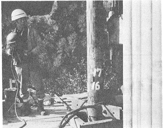
写真2 ストレナーを切った200m/m鋼管の溶接
