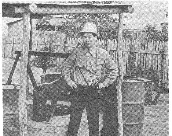
写真24 曾我部調査団長とアンボボンベの浅井戸。深度は15m。水比抵抗1,200Ω-cm。水温は26.3°C。この地方の地下水として非常に良質の部類にはいる。
