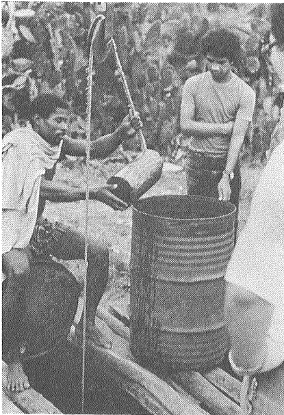
写真26 ボボ(す掘りで井戸枠がない浅井戸) 原始的な井戸であり 井戸の上に桶を渡すだけで 井戸枠がない 危険でもあり 不衛生でもある
