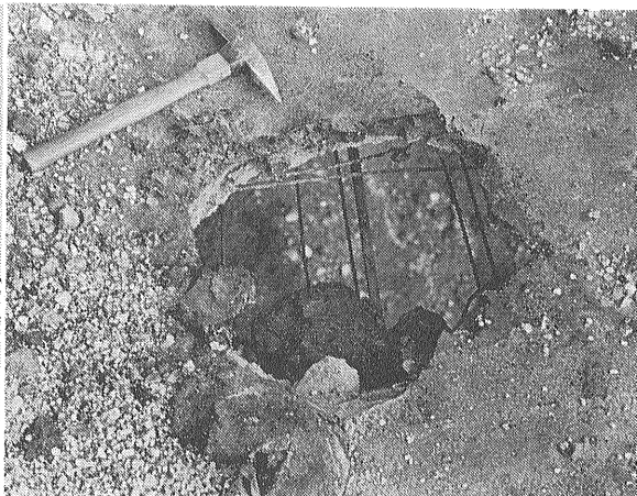
写真5 厚さ25cmのコンクリートを破り 鉄筋でとまった岩塊。
