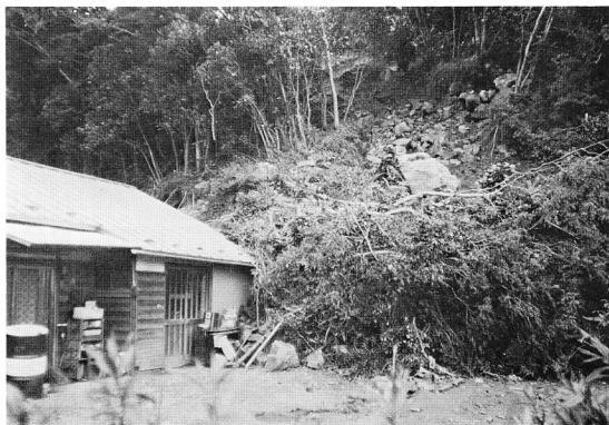
宮城県沖地震時に発生した 松島湾沿岸旧海食崖における斜面崩壊
