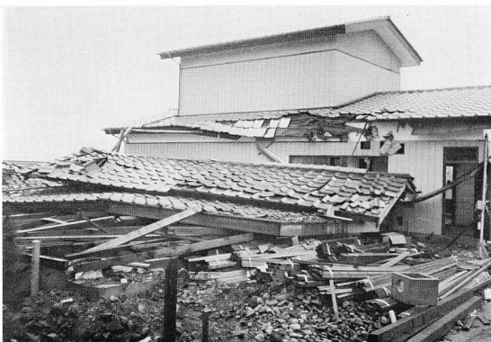
宮城県沖地震時における 木造住宅建築物の倒壊 この地域も沖積低地帯である これに対し段丘上の旧市街地における倒壊は見られなかった
