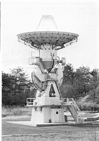
写真1 口径 10m アンテナ (XYマウント) アンテナ制御卓からの指令で LANDSAT を追尾する
