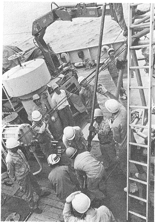
写真 9 6 m 長のコアパネルを取りはずす作業
