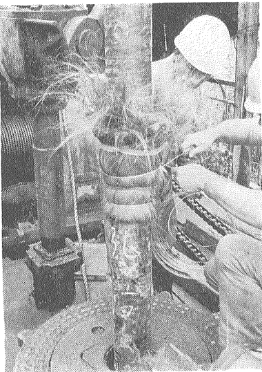
⑭ 中間遮水に使われたシュロパッカーのまきつけ
