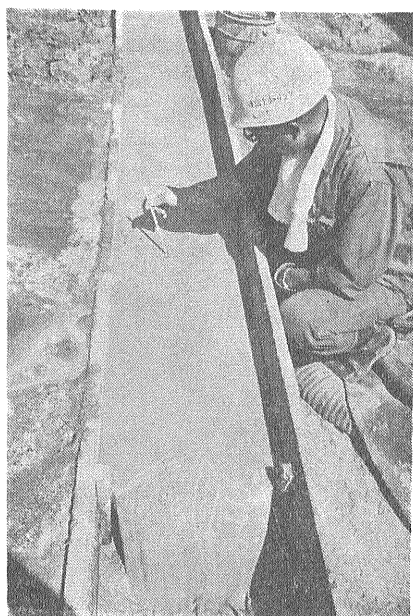
⑤ 掘削中の泥水温度の測定
