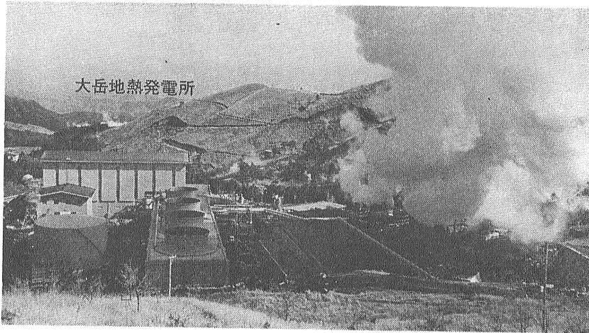
④ 昭和52年に運転開始された八丁原地熱発電所。大分県玖珠郡九重町にある。九州電力(株)による。左後方の噴気は大岳発電所である。両発電所間の距離は2 kmである。
