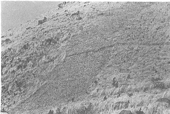
写真23 浅間山断層の拡大写真. 縦ずれ変位が大きく地すべり性の地割れと思われる (Loc. 24).
