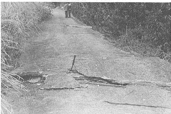
写真21 右横ずれの断層運動により 路面が短縮されたため 路面が浮いて互いに重なりあっている (Loc. 19).
