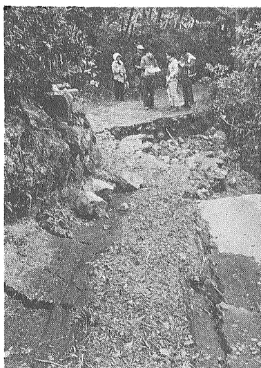
写真16 山道を切る断層。 右手は谷のため道が崩れ落ちている (Loc. 16).
