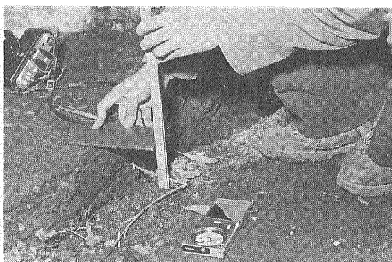
写真10 断層の垂直変位量を測る。約8cm北側の地面が落ちている。断層面に条線を見ることができる(Loc.10).
