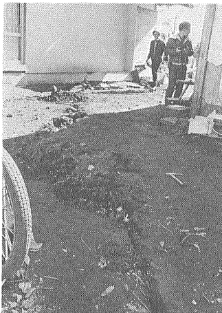
写真7 家の裏庭を通る断層。写真の手前から見ると単にずれるだけの部分、圧縮され盛り上げている部分、開口している部分とでそれぞれ割れ目の方向が異なっていることに注意。1月14日の本震により割れ目が生じたが、その時には盛り上がりはなく翌15日の最大余震時に盛り上がりが生じたという (Loc. 10)。
