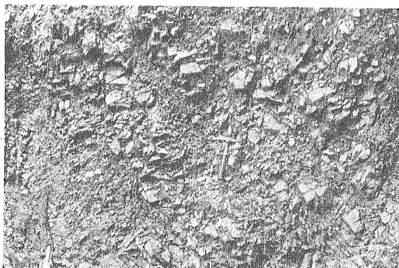
写真1 断層角礫岩(破碎度②) 加子母村塞ノ神谷 結晶凝灰岩(阿寺層)
