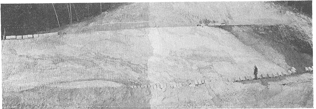
写真8 中央道細野付近の切削（地点B）すべて伊奈川花崗岩を母岩とする断層粘土で 右端近くに N15°W70°Eの断層があるほかはほとんど水平の不規則な縞模様を示す。（1973年3月10日撮影）
