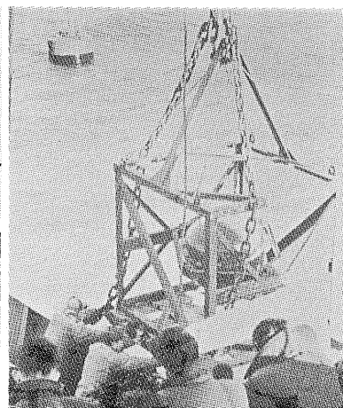
第3図 「東方紅」号での自動験潮機の投設作業
