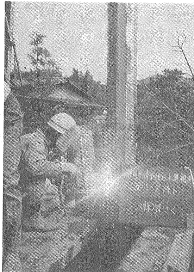
写真4 ケーシング熔接中
