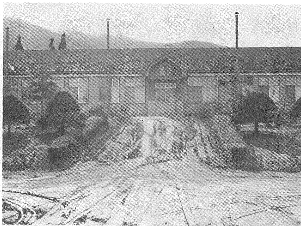
第17図 虻田町月浦小学校の降灰(校庭には10cmの軽石・火山灰が堆積している)
