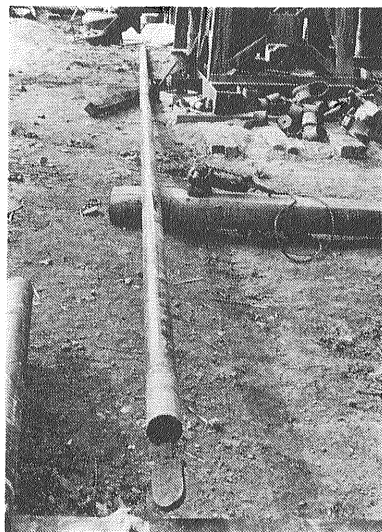
㊤ ベーラー 3"ガス・パイプで作った。長さ10m。
