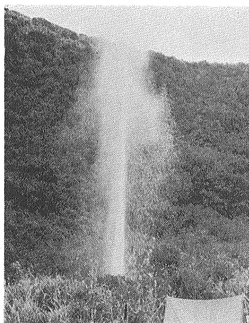
写真7 拡底発破の瞬間
