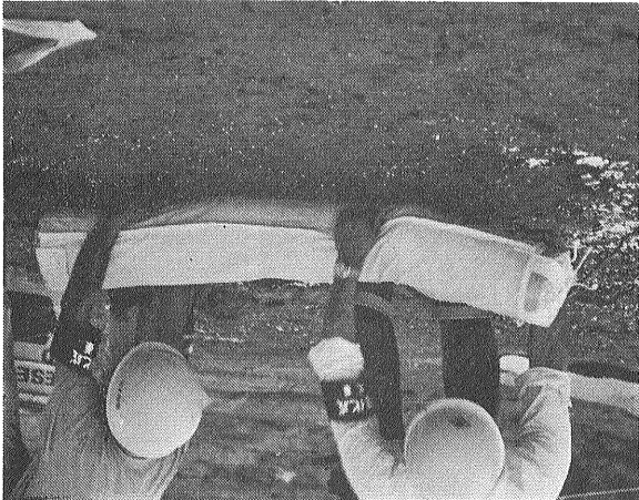
写真15 径の大きい鋼ダイ 布製の袋に入れて挿入される（川崎市扇島の爆 破作業）
