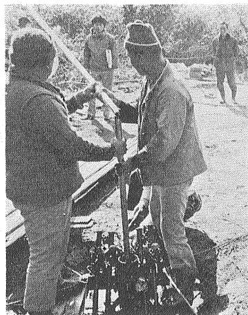
写真11 ジュラルミン製 込め棒による爆薬の挿入作業
