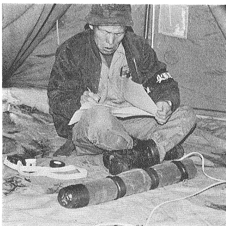
写真6 拡底発破のための雷管付爆薬の作成
