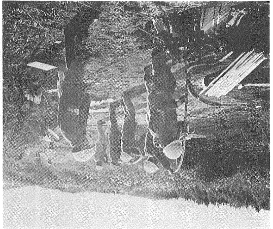
写真14 導線を保護する竹ヒコが延々と続く 爆薬の装てん作業も これで終る。
