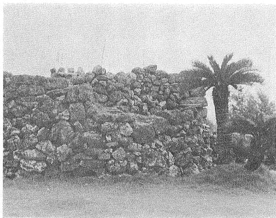
第5図 石垣遠目台(積みあげてある石は全部石灰岩である)
