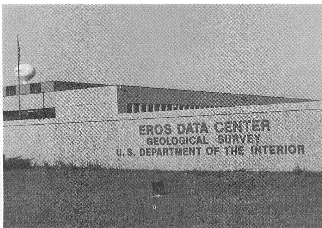
図4 データセンター入口付近
