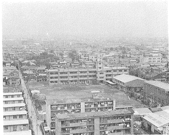
写真1 地盤隆起地帯の西端部（川崎市木月小学校付近） 校庭左手前が工水5号井 この学校から向うの高層アパート群 さらに新幹線の右手にかけて工水井群が散在している。
