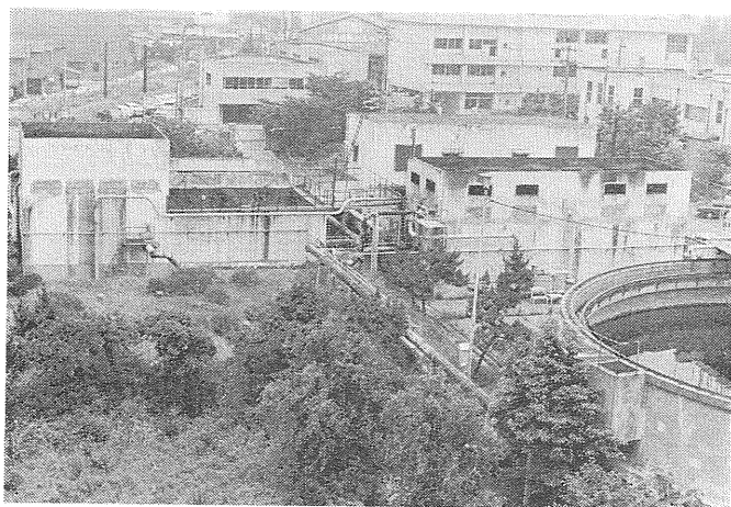
写真2 地下水を得るために工場から4kmも離れた旧河道上に設けられた揚水井群と水処理施設 現在使用されていない。
