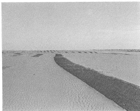
第10図 砂漠道路の砂防 crude oil (石油)を帯状に道路に沿ってまき 砂の侵入を防ぐ 非常に効果的
