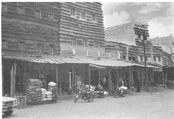
第11図 ルブアルハリ砂漠の玄関 ナジェランの商店街 日乾したレンガにプレカンプリアの片岩をはさみこみ 泥で固めた建築は 他の地方と全く異なった町並を呈する
