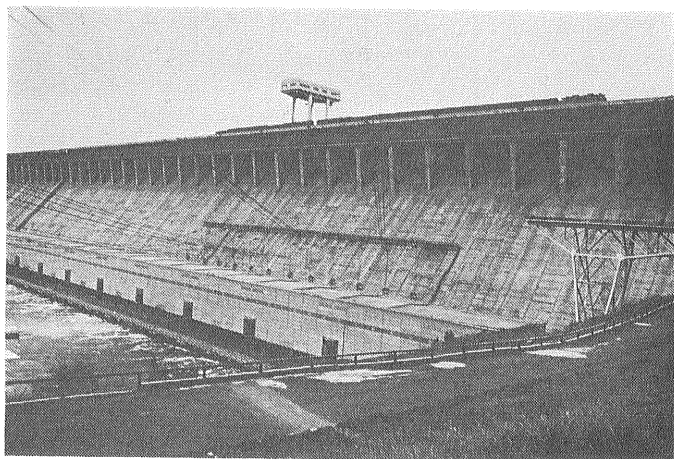
第3図 シベリアの水力エネルギーの開発は急激に進みつつある。ここブラツク発電所から平均450万kW/hの電力が送り出され、2つのアルミニウム工場を初めツルーン市のガラス工場も その恩恵に浴している。ダムサイトの上を走る列車は 1車両16t積を40両ばかり引いて行く ダムにせきとめられた人造湖の面積はビロ湖の8倍を越えブラツク海と呼ばれている その発電原価 1kW/h 24銭!
