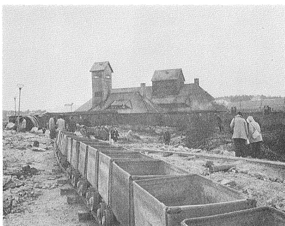
写真5 研場からみた古いツィノベックの選鉱場
