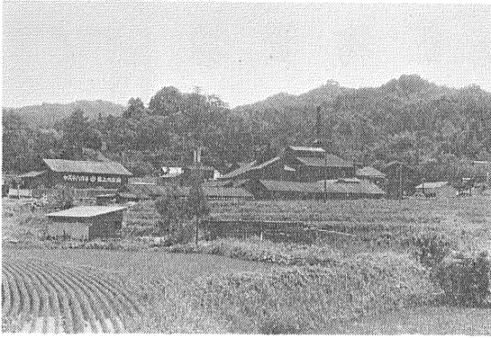
写真8 島上木炭銃工場(1974年6月写) 島根県横田町大呂にある。近年の山砂鉄製鉄の中心であった。現在では山砂鉄精鉱100 t/年(十旧低品位鉱200—300 t) 川砂鉄200 t/年(斐伊川) 海岸砂鉄2,000 t/年の生産を約20名でおこない安来の日立金属(株)に送り 特殊鋼の原料としている。写真真煙突の右側には靖国たたらがあった。これは昭和8年に軍用日本刀作成のため復元されたもので 20年まで用いられた。現在では建屋と記念碑があるにすぎない。
