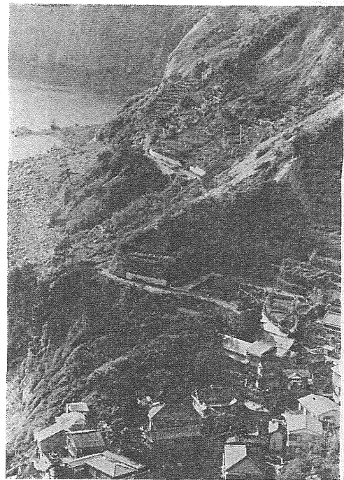
写真⑫ 落居地区西海岸の崩壊
