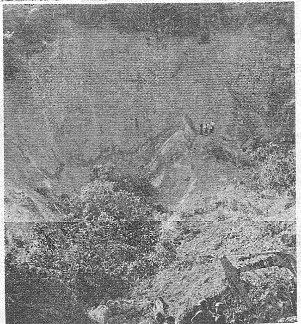
写真⑨ 27人の犠牲者を出した中木地区の地すべり性崩壊 白くすじ状に見える部分は凝灰岩の新鮮な部分 その上は風化のすすんだ崩土 凝灰岩と崩土の間から水が滲み出している。
