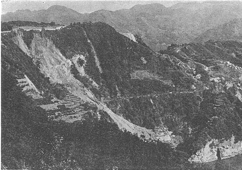
写真25 落居地区東方の崖くずれ 新築中の家を押しつぶした。
