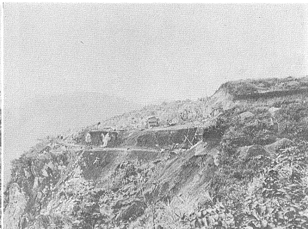
写真2 しかし上に登ってみると「表土」が結構厚いのには驚く～ドロハギ作業～(葛生地区A鉱山)
