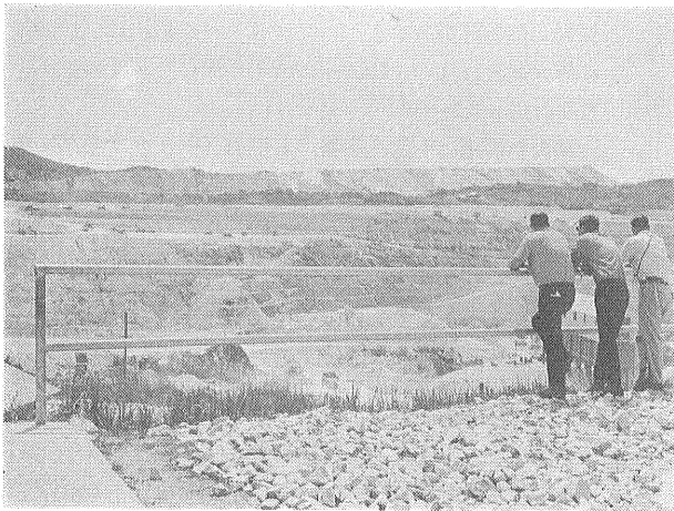
写真5 スンゲイ・ベシ鉱山の露天掘現場 沖積世漂砂(錫石を含む)が風化のためこれとほとんど区別できないほど粘土化した花崗岩体の上に堆積している
