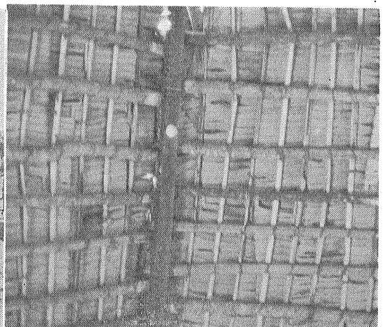
第12図 家の内側からみた屋根。太い材木(この写真のように角材を使っていることは少ない)に丸太を載せ その上に竹を載せて萱で葺いてある。釘は使われず 丸太や竹はすべて蔓でしばってある。
