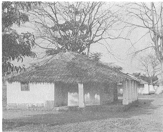
第10図 ポオウカの宿舎。乾燥煉瓦を積重ねて白ペンキを塗った壁の上に萱葺きの尾根を載せたもので 内部は涼しい。内部は居間と三つの寝室 水浴び場に分かれており 炊事は裏の軒下でするようになっている。
