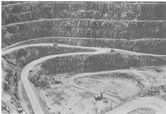
① マウントライエル鉱山 西ライエル鉱床の露天掘
