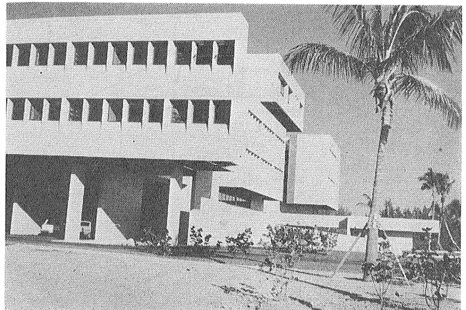
第11図 大西洋研究所のビル。地質部 海洋部 ハリケーン研究所などがある。マイアミの沖の平らな島 Key にありハリケーンの高潮に備えて床が海抜 5.3 m になっている。職員約 200 人。
