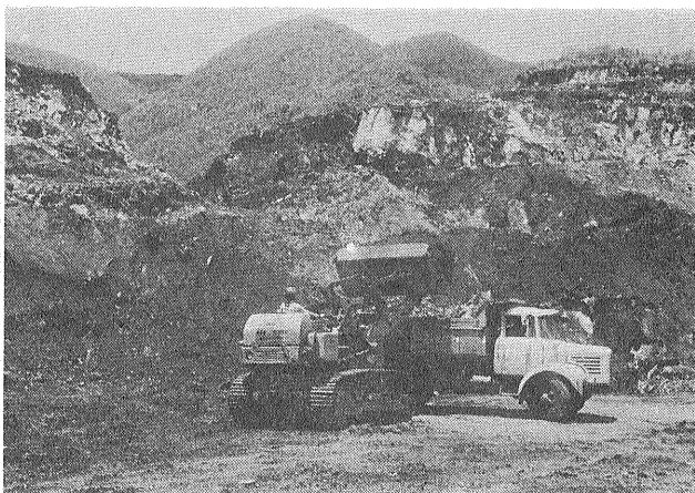
⑪ ニッケル鉱石の採掘。ラテライト質鉱石であるため ほとんど火薬を使用することなく ブルドーザーおよびローダーを使用して採掘している。
