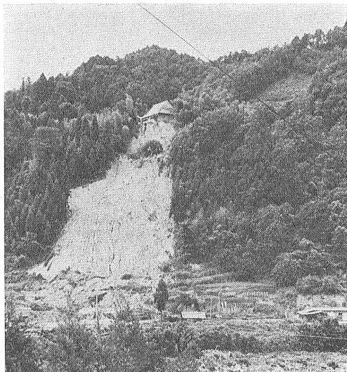
写真⑥ 小原村平畑の崩壊 下部の住家が倒壊し死者7名を出した。2段に崩れ落ちているが 上段は上の人家の下から Slump 状にくずれ 下段は斜面上をけづり取った。
