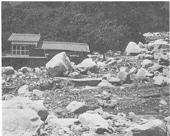
④ 姫戸町西河内の土石流 巨礫・岩塊を含む山津波によって集落はほとんど埋没してしまった
