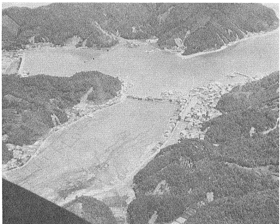
⑤ 西河内下流側の泥流 水田は全く消失した
