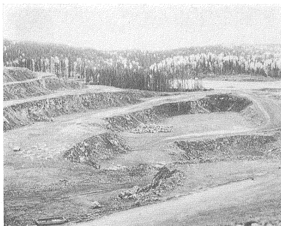
写真⑤ カナダ グラナイル 鉱山 露天掘
