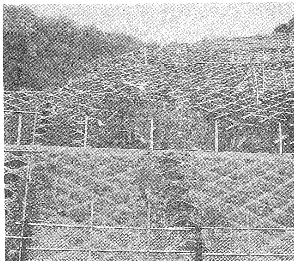
写真⑨ 破壊された法面枠止め
