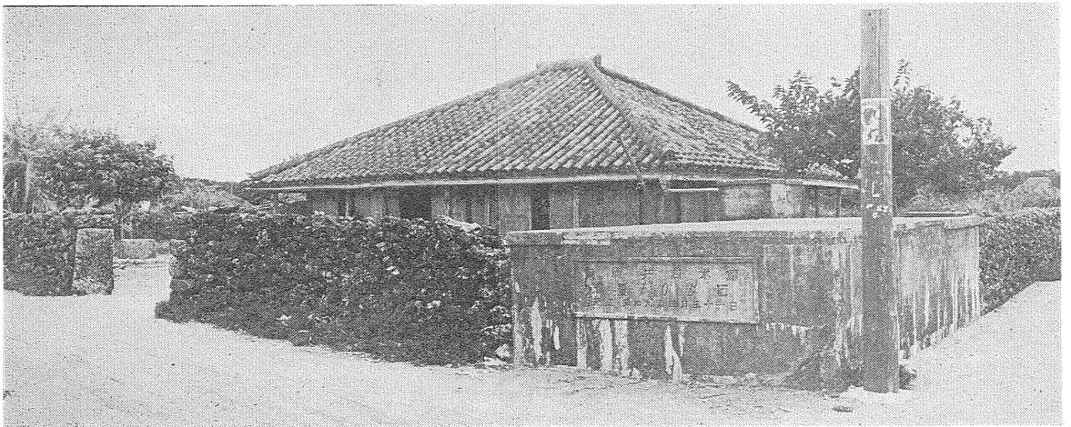
写真⑤ 東筋にある天水を貯める共同水槽 容量105石 竣工 昭和9年3月31日とある
