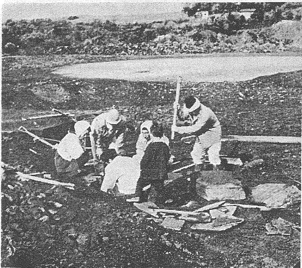
写真4 ヘリポートの作業現場
