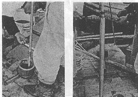
第6図 ガイドパイプ孔(作業中)
