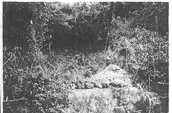
第6図 [1]—A—(a)の例。 下位の泥質火山灰層は きわめて 軟かいが 全く崩れていない
