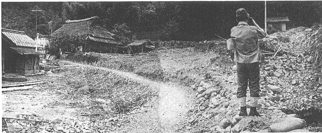
写真5 沖積扇をけずって道路や宅地を作っていた所 今度の豪雨でもとの沖積扇に戻った なお撮影時には旧状に復帰していた。 左はしらの家の壁に注意
