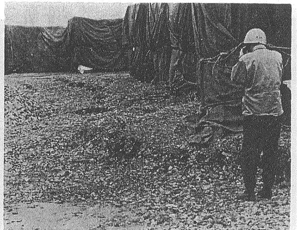
写真13 新設工場敷地で 段ちがいの右側は砂丘 左側は砂鉄採掘のあと
