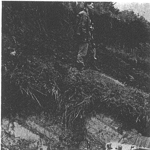
写真5 山くずれの層準 立っている人の足もとが“すべり面” それから上は表土と上部ローム層 下は八戸浮石層。
