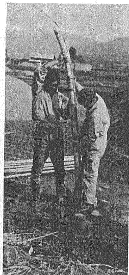
写真3 発破坑に火薬をつめる(宇部興産提供)
