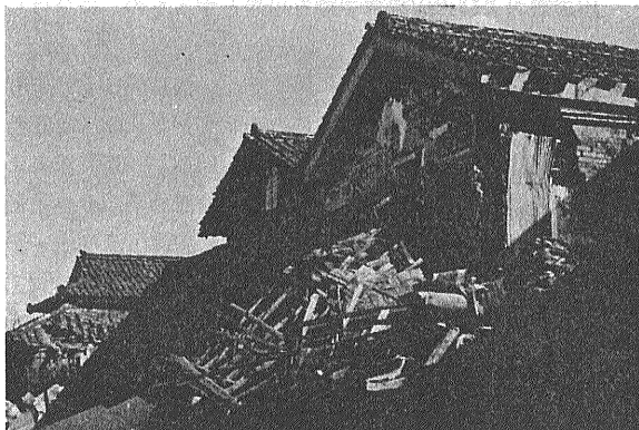
木屑と化した倉庫の付属木造建物（京町温泉）
