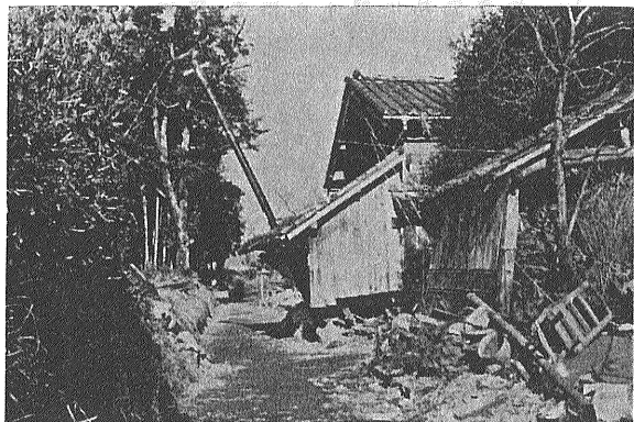
傾いた家屋と電柱（幣田）
