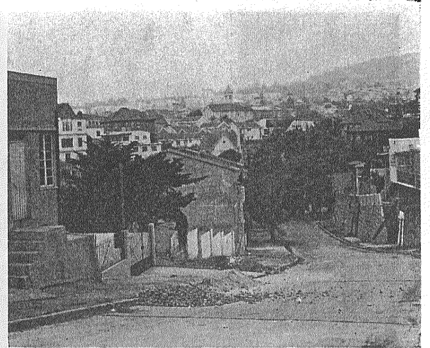
写真-56 ビニヤ デル マールの町のただずまい 手前には古い家が建ちな らんでいるが 遠方には近代的なアパートが続々と建ちつつある
