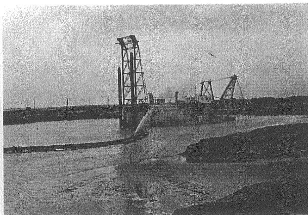
第9図 掘込港湾の開さく工事〔茨城県鹿島郡神栖村〕(相原撮影)
