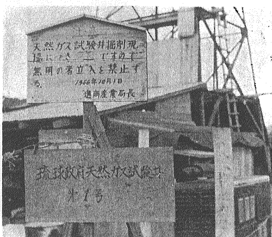
那覇1号井掘さく現場入口
