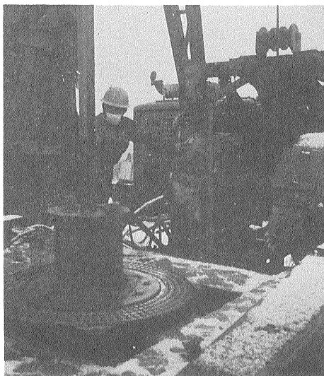
由利原 ST-1号井掘さく中 ドローワークスは 4 7/8"ユニットタイプ改良型 ロータリーテーブル 17 1/2"オイルパス
