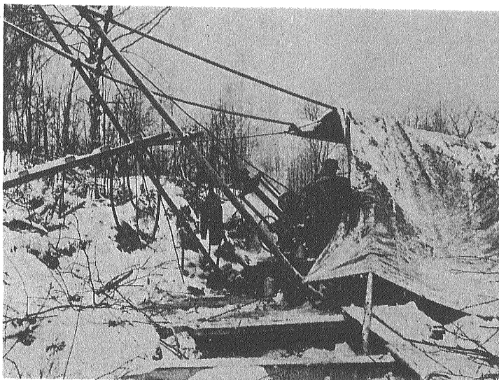
北部スウェーデンにおける探鉱用試錐 Photo：Per H. Lundegardh 1960 ©
