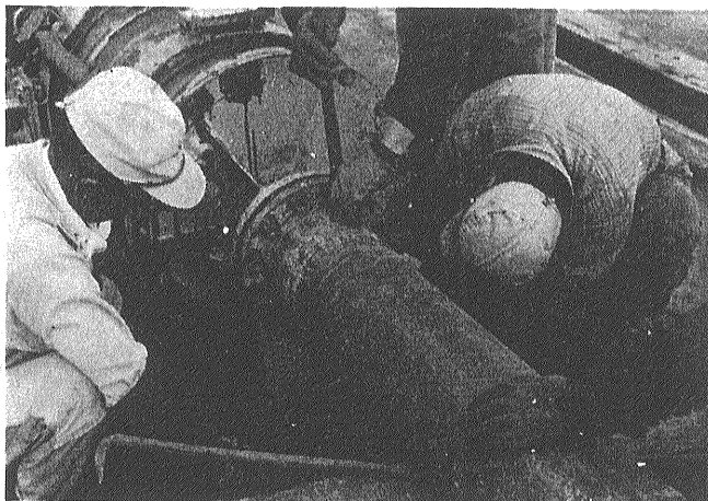
振動機にコアチューブを取付ける
