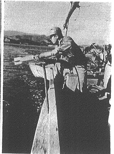
水中受波器 中央手の所にチタバリ型ハイドロホンおよび結合用トランスが収められている
